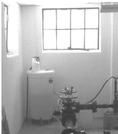
16. ábra. A vízművek szivattyúháza
